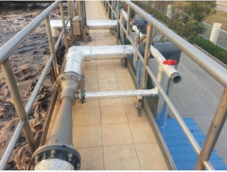
极大部分臭氧在污水池进行氧化反应之后又回到氧气形态。将这部分氧气抽取用于曝气，取代原有空气曝气系统，将极大降低曝气电耗，从而降低污水处理厂的综合运行成本。GW射流器系统因其抽气能力大、传质效率高、安全性高安装简便（可不放水安装）、性能长期稳定可靠，成为这一应用领域的最优选择。
